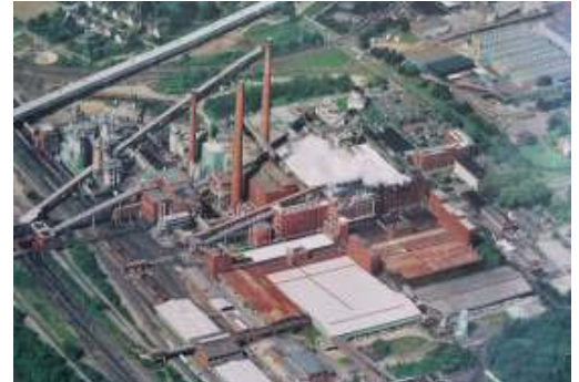
Luftbild eines Fabrikkomplexes, für den eine Lärminderungsplanung durchgeführt wurde
